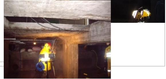
• Planta de Valorización energética de Sant Adrià de Besòs. Obras de rehabilitación de la estructura de hormigón, foso de escorias. Barcelona
